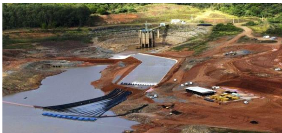
Figura 2.34 - Sistema Cantareira: captação de água da reserva técnica (volume morto), por meio de bombas flutuantes.
