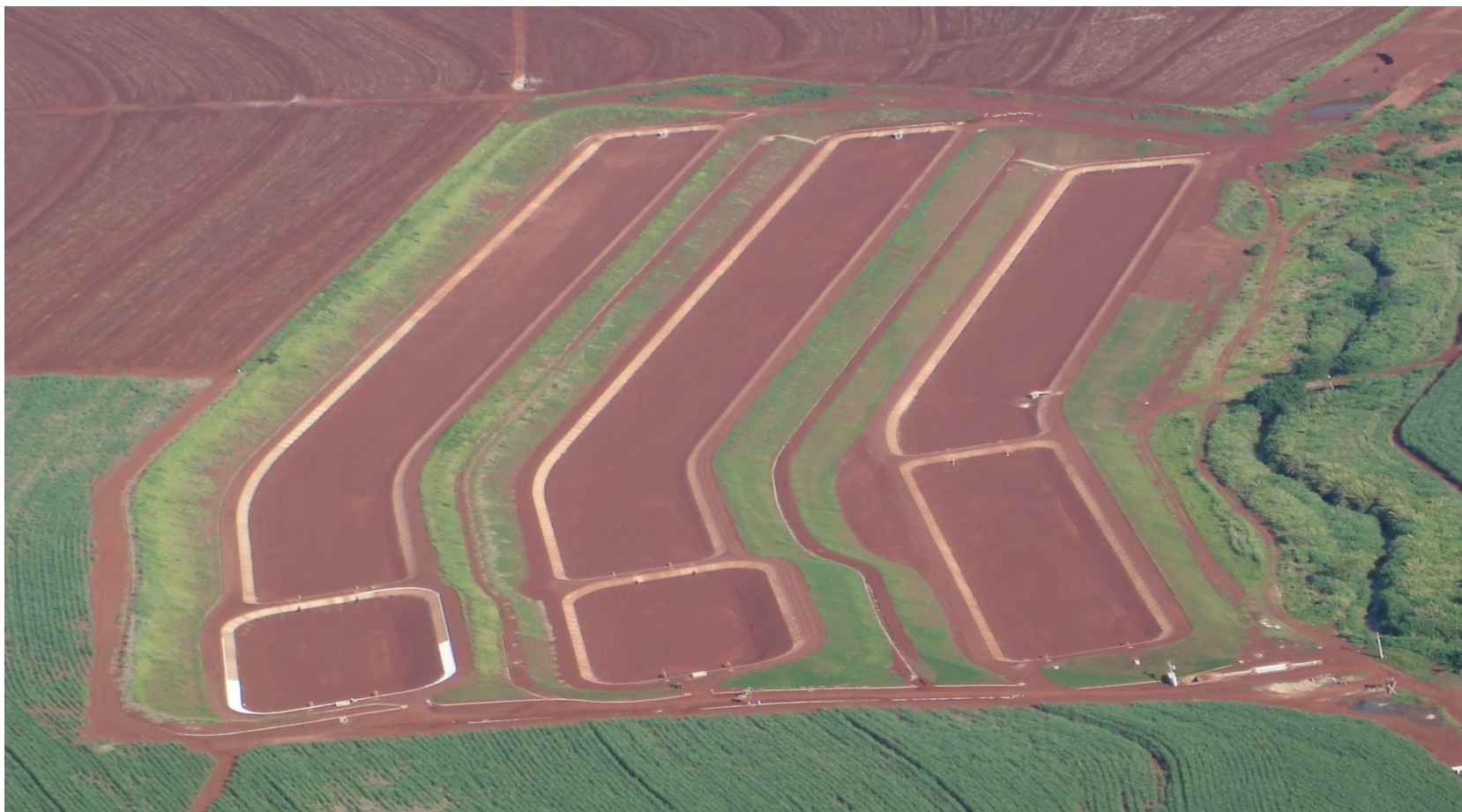
Construção das lagoas de tratamento de esgotos de São Manuel
