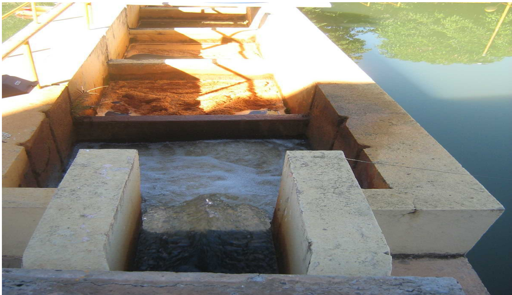
Tipo de floculador (chicanas)
