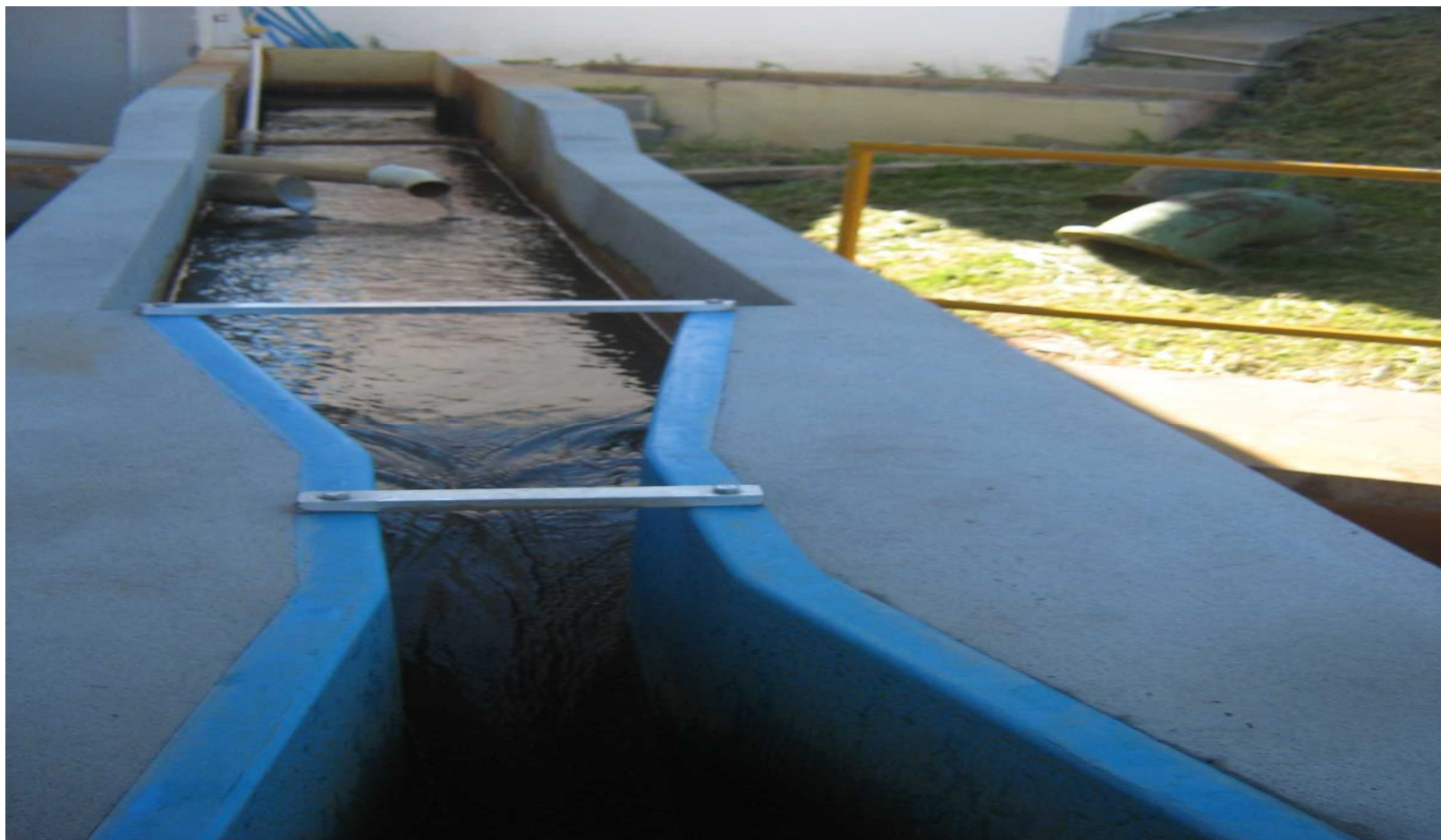
Calha parshall (medidora de vazão)
