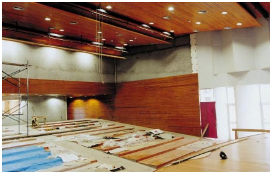
Em fase acabamento, o moderno auditório terá capacidade para 219 pessoas
