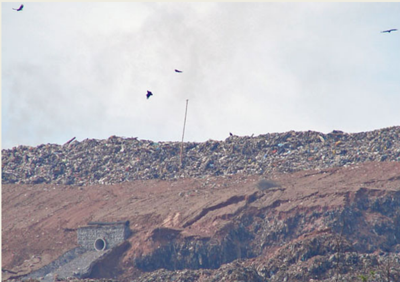
Deslizamento de Agosto de 2008 Aterro São João
