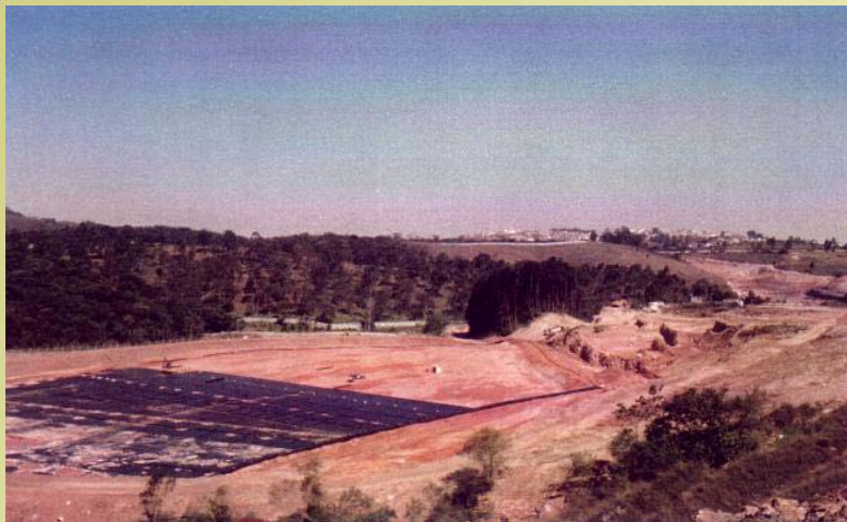
Vista 2 da célula em fase de impermeabilização com Geomembrana de PEAD
